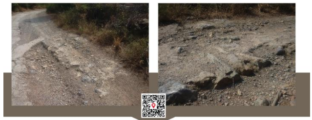
Camí empedrat de la cimentera de la Sanson
